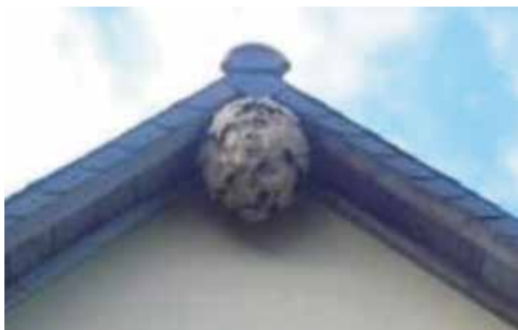
Nid installé sous débordement de toiture ;
